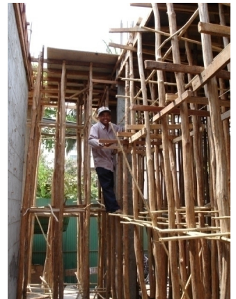
Deckenschalung "unterstützern"
